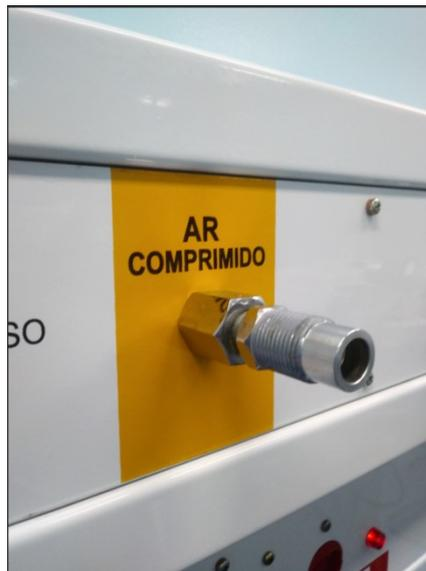
*Figura 2 – ITEM 2: CONEXÃO MEDICINAL DE AR COMPRIMIDO*
