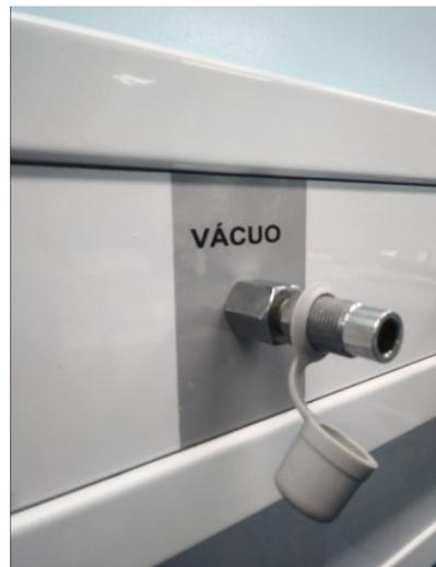
*Figura 4 – ITEM 4: CONEXÃO MEDICINAL DE VÁCUO*
