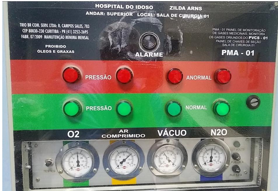
Figura 20 – PAINEL DE ALARME / MONITORAMENTO OXIGÊNIO / AR COMPRIMIDO / VÁCUO / ÓXIDO NITROSO
