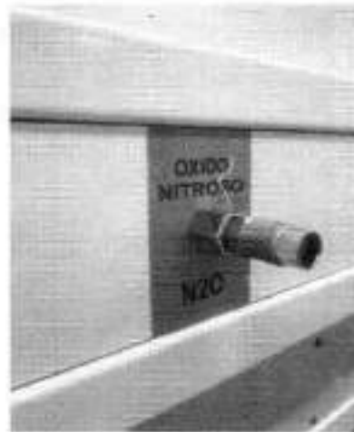
Figura 3 – ITEM 3: CONEXÃO MEDICINAL DE ÓXIDO NITROSO
