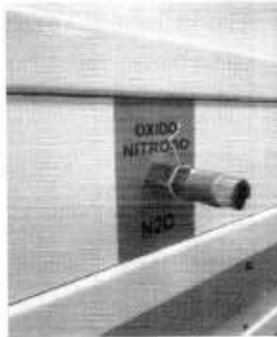
Figura 3 – ITEM 3: CONEXÃO MEDICINAL DE ÓXIDO NITROSO
