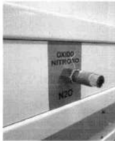
Figura 3 – ITEM 3: CONEXÃO MEDICINAL DE ÓXIDO NITROSO
