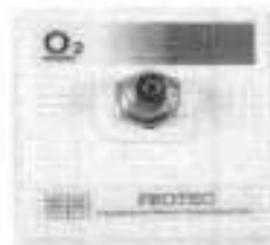
Figura 14 – ITEM 19: POSTO PAREDE EXTERNO (CANOPLA) OXIGÊNIO
