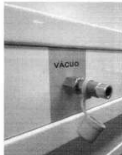
Figura 4 – ITEM 4: CONEXÃO MEDICINAL DE VÁCUO
