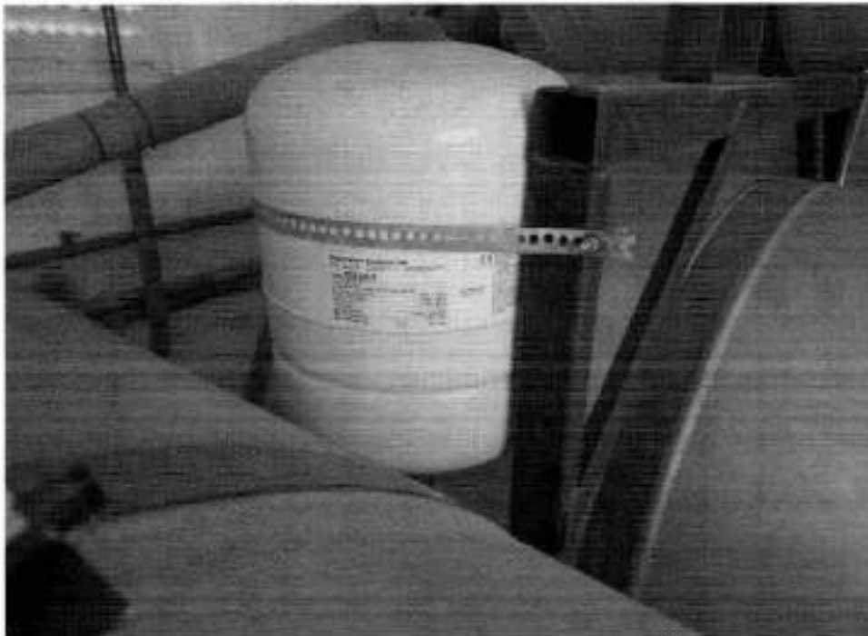
Figura 5 – Vaso de Expansão HMIZA:
