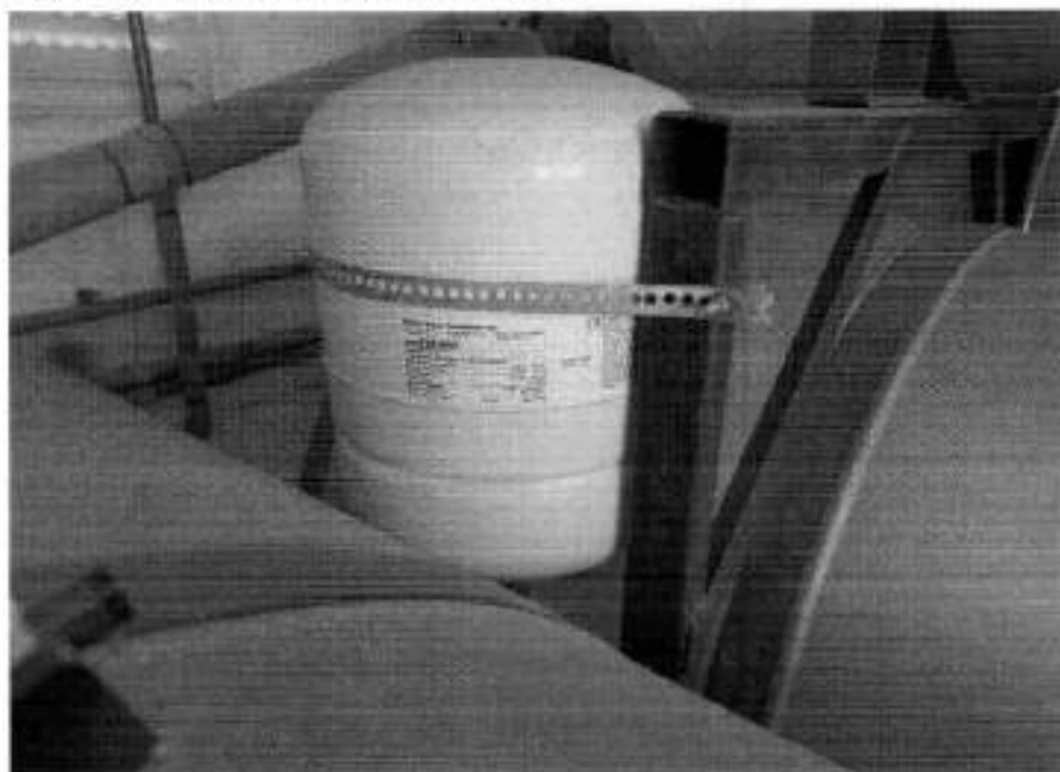
Figura 5 – Vaso de Expansão HMIZA:
