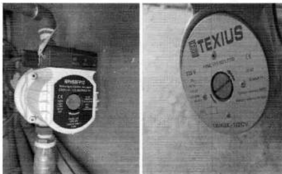
Figura 2 – Bomba (CIRCULADORA DE ÁGUA) Pressurizador HMIZA:
