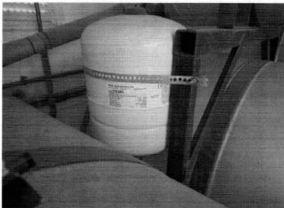
Figura 5 – Vaso de Expansão HMIZA:
